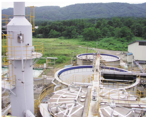
二本木工場の排水浄化処理工程の活性汚泥沈殿槽。
