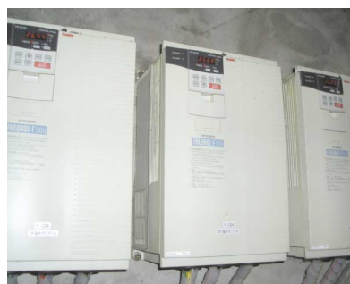
電解のポンプに設置したインバータ設備 (高岡工場)
