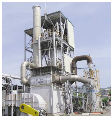
高岡工場の排ガス燃焼炉。 有害物を含む排ガスを焼却除害する設備です。
