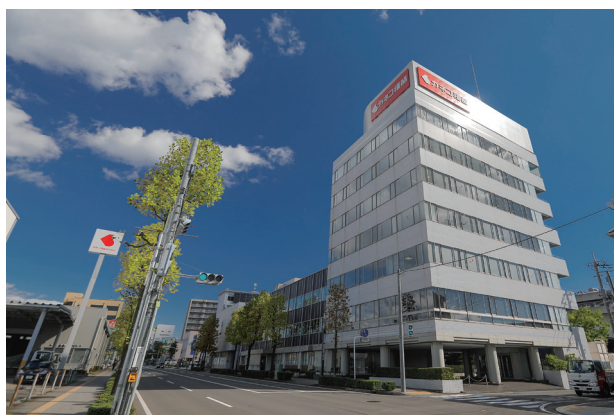
写真1. カネコ種苗株式会社 本社ビル
