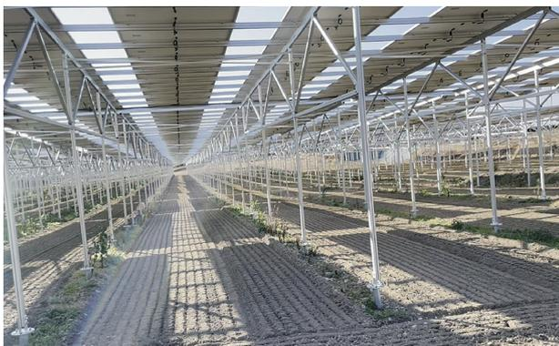
図3. 農地の上に背の高い架台と太陽光パネルを設置する「ソーラーシェアリング」
