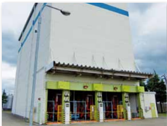
高岡工場 危険物立体自動倉庫
